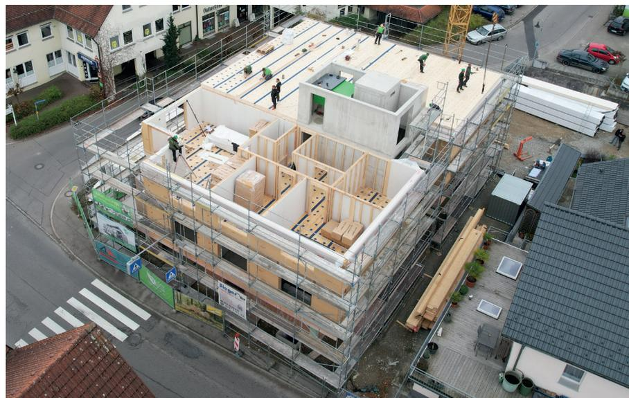
Im Vergleich zu einer einschaligen Massivholzdecke, kann mit der CLT BOX – DECKE FS der Materialeinsatz um bis zu 40 % reduziert werden – bei gleicher statischer Leistungsfähigkeit. Der Grund hierfür ist die Hohlkastenform.
