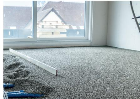
Auf der Baustelle wurde auf die Oberseite der CLT BOX der BOUNDSPPLIT aufgebracht – eine schallabsorbierende Schüttung, die der Estrichleger wie gewohnt mit der Estrichpumpe fördern und mit einer Setzlatte flächig abziehen kann. Installationen können so leicht in der Ebene des BOUNDSPPLITTS integriert werden.
