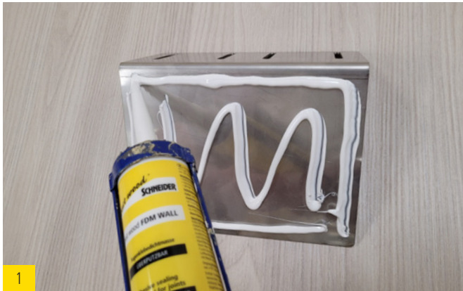
1 Appliquer FDM WALL sur l'équerre. Pour le nombre d'équerres, voir le tableau.
