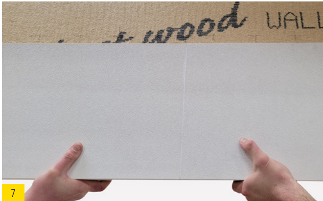
Insérer le LAMBREQUIN à deux personnes dans la cavité préparée.
