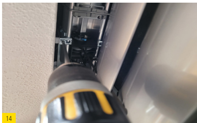
Aligner le brise-soleil en largeur et serrer légèrement les vis sur le support.
