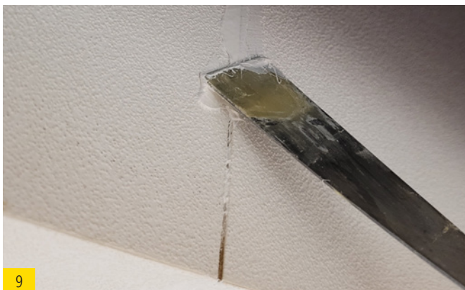
En cas de jointures ouvertes, ceux-ci doivent être colmatés avec FDM WALL.
