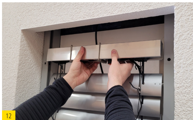
Introduire le brise-soleil préparé dans la niche ...
