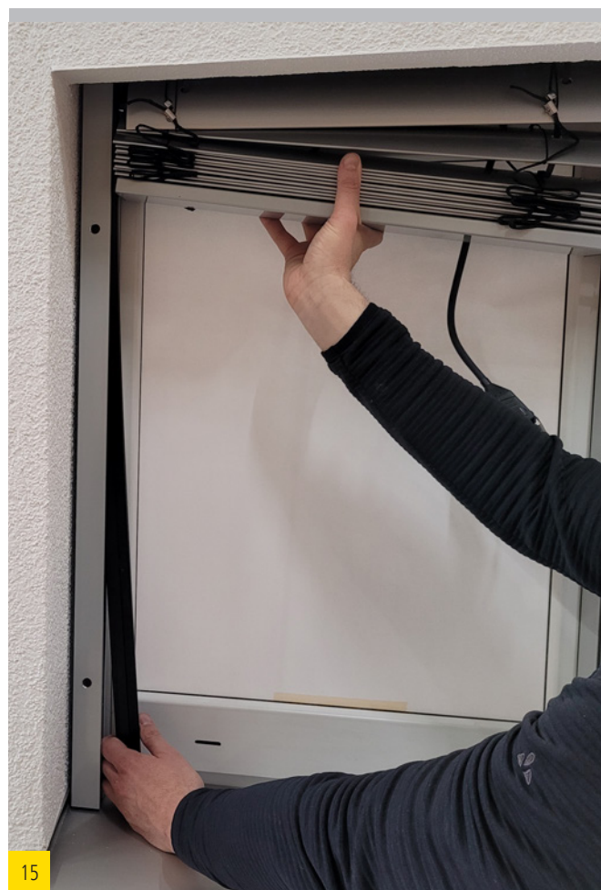
Introduire les inserts pour coulisse et les encliqueter correctement.
