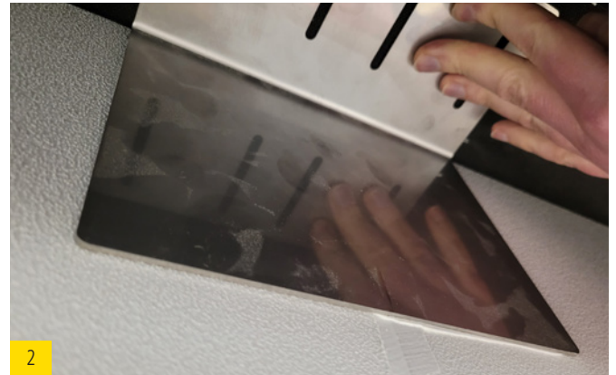
2 Presser l'équerre à l'arrière du lambrequin.
