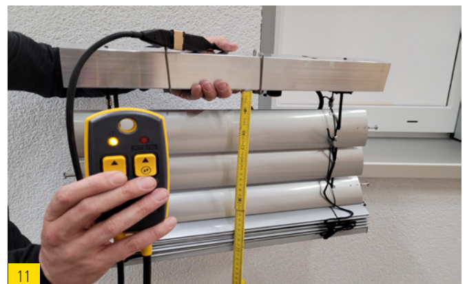
Raccorder le câble moteur et déplacer le brise-soleil d'environ 20 à 30 cm vers le bas.
