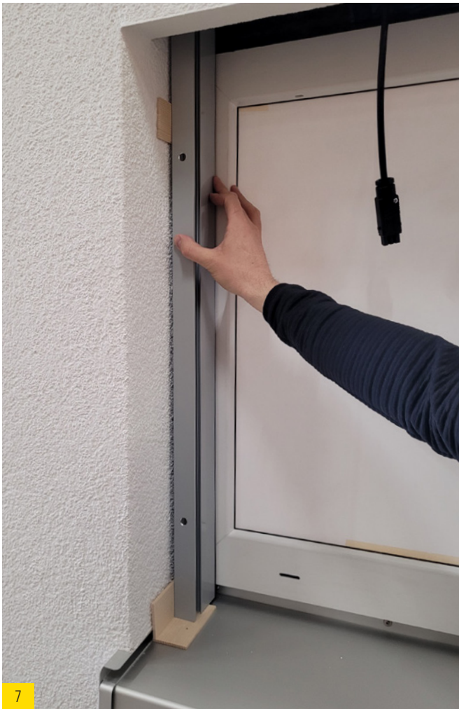
Aligner les coulisses verticalement et parallèlement.
