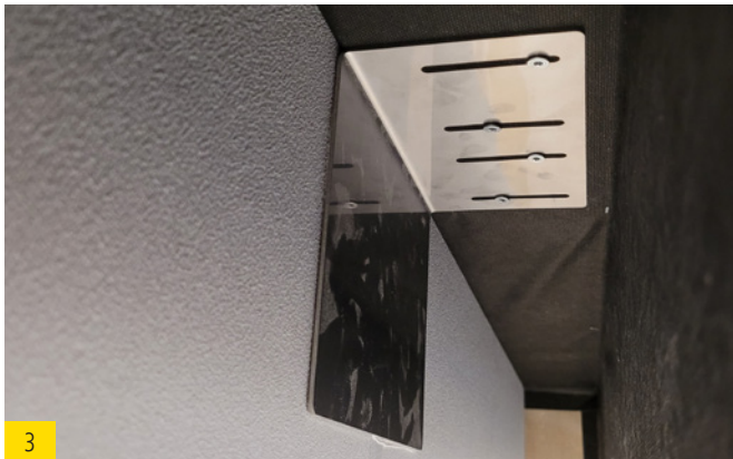
3 Visser l'équerre dans la traverse avec 4 vis de 4,5 x 40
