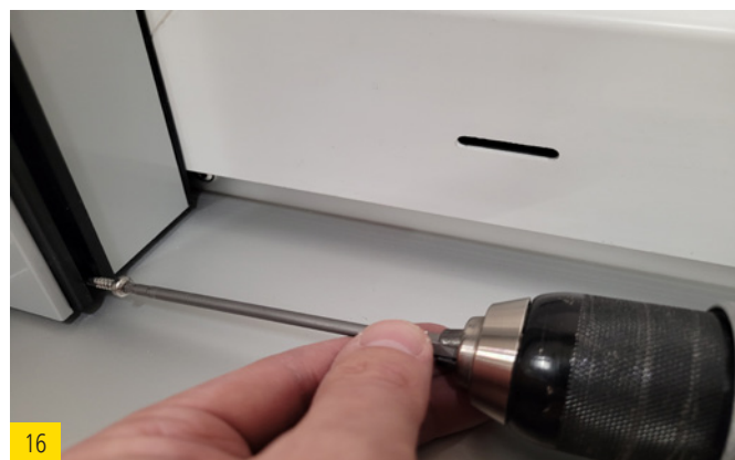
Monter la vis de sécurité.
