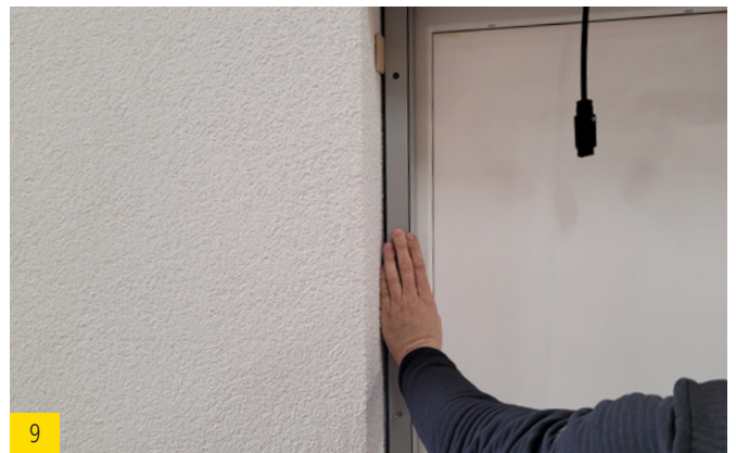
L'écart par rapport à l'enduit doit être \geq 5 mm.
