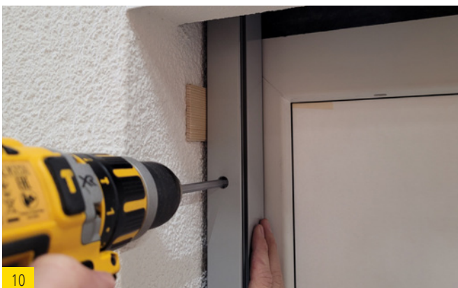
Monter les coulisses avec les vis fournies.
