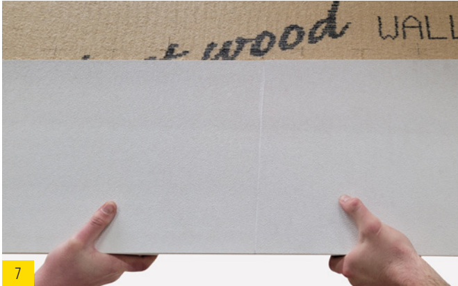
7 Insérer le LAMBREQUIN à deux personnes dans la cavité préparée.
