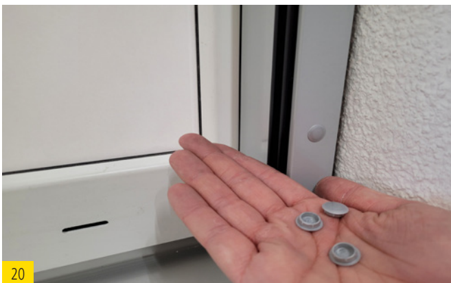
20 Fixer les caches sur les coulisses.
