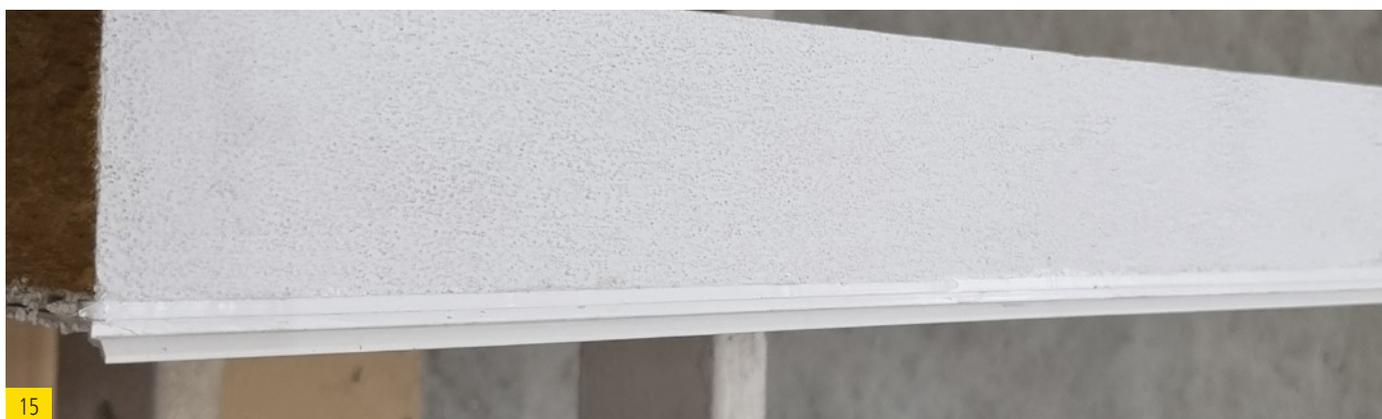
Après le séchage de la FDM Wall, la face inférieure et la face arrière DOIVENT être peintes avec une peinture pour façade afin de garantir la fonctionnalité du revêtement.
