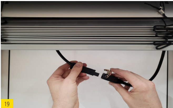
19 Raccorder les câbles à l'aide des connecteurs Hirschmann. Fixer le câble à la traverse supérieure avec le collier de serrage fourni.
