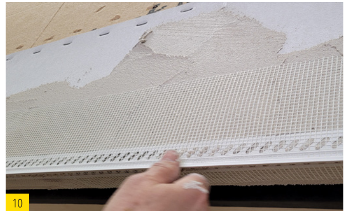
10 Lors de la mise en œuvre du profil goutte pendante, découper le treillis sur la face inférieure afin qu'il ne dépasse pas du LAMBREQUIN. Le joint du LAMBREQUIN et le joint du profil goutte pendante doivent être décalés.
