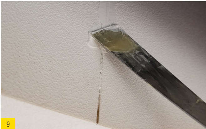
9 En cas de jointures ouvertes, ceux-ci doivent être colmatés avec FDM WALL.
