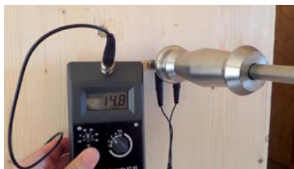
Humidité d'une construction d'ossature bois \leq 18\% .
