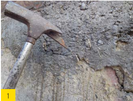
1 Retirer les couches de crépi que ne tiennent pas.
