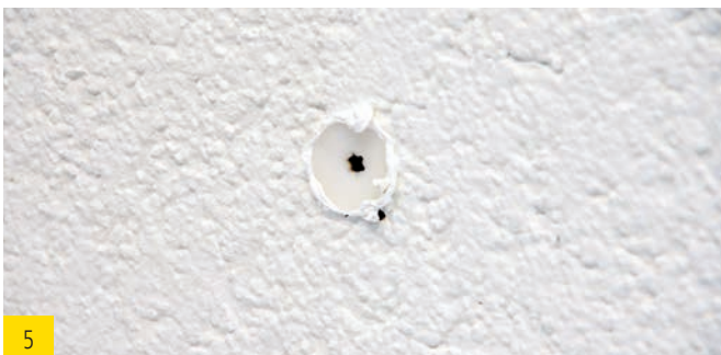
5 Retirer le surplus de masse FDM WALL.
