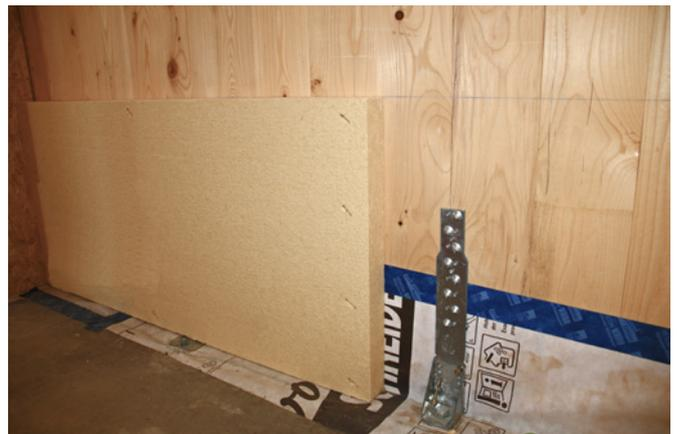
Alignez horizontalement le bord supérieur de la 1<sup>ère</sup> rangée de panneaux à l'aide d'une ficelle.
