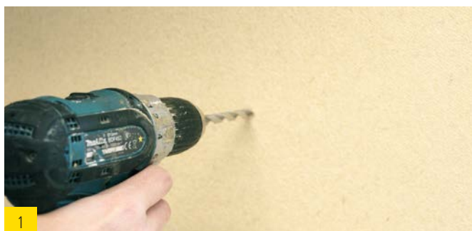
1 Pré perçage du panneau sans crépi, mèche de 8 mm.
