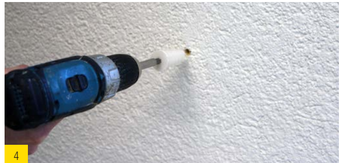
4 Visser la cheville affleurée à l'aide d'un embout T40.
