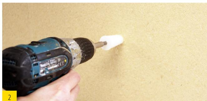
2 Visser la cheville hélicoïdale à l'aide d'un embout T40 dans un panneau sans crépi.
