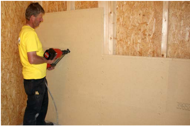
Fixation à l'aide d'agrafes à dos large.
