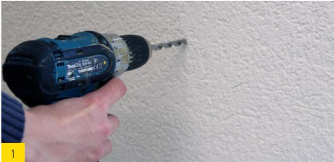
1 Pré perçage du panneau crépi, mèche de 8 mm.
