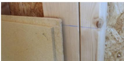
Alignez horizontalement le bord supérieur de la 1<sup>ère</sup> rangée de panneaux à l'aide d'une ficelle.
