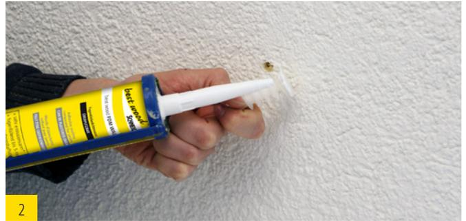
2 Appliquer la masse de jointoyage crépissable best wood FDM WALL pour étancher.
