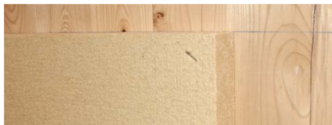
Alignez horizontalement le bord supérieur de la 1 ère rangée de panneaux à l'aide d'une ficelle.
