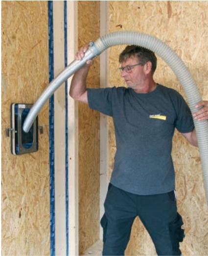
La mise en œuvre de best wood FIBRE se fait au moyen de souffleuse-cardeuse adaptée à la fibre de bois. FIBRE sera aspirée et transportée sous pression dans les tuyaux. Elle remplira les cavités désirées du bâtiment à isoler et sera densifiée selon les directives de ce document. L'emploi de FIBRE devra se faire par du personnel préalablement formé et qualifié pour garantir une mise en œuvre correcte et stable.
