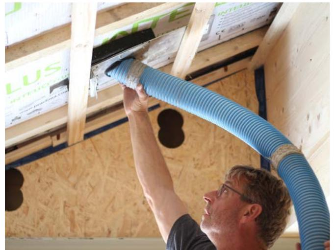
Remplissage de construction de toit avec insufflation à l'aide de tuyaux
