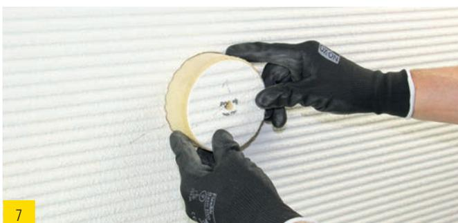
7 Reboucher le trou avec le bouchon obtenu lors du perçage ...
