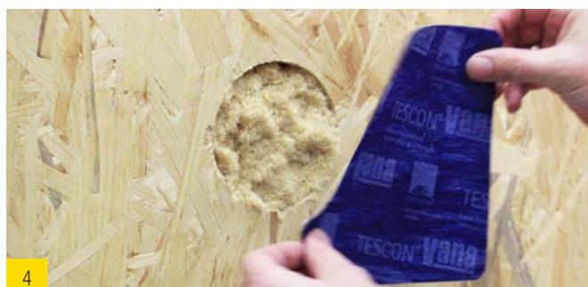
4 Refermer l'ouverture au moyen de patch autocollant ou de bande adhésive
