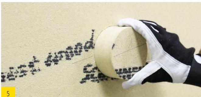
5 Reboucher le trou avec le bouchon obtenu lors du perçage ...
