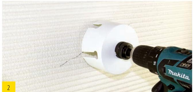
2 Effectuer le perçage de la couche de mortier avec la mèche cloche LH
