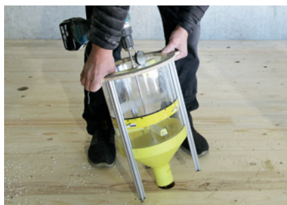
Placer l'aide au remplissage EASY FILL sur l'ouverture de la CLT BOX – DECKE FS
