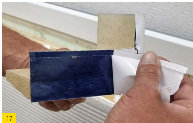
17 Retirer la bande de protection du ruban adhésif à l'arrière des extrémités de cale d'étanchéité.
