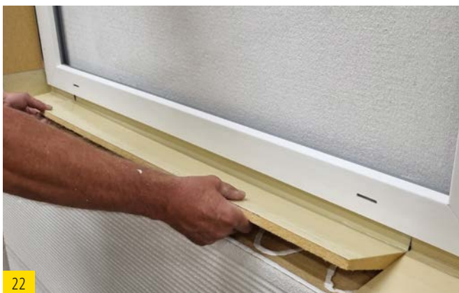
22 Enfoncer avec précision la cale d'étanchéité entre les extrémités de cale d'étanchéité.
