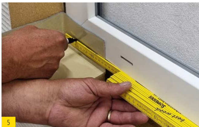
5 Tracer la lèvre des extrémités de cale d'étanchéité en hauteur sur le bord inférieur de la fenêtre.
