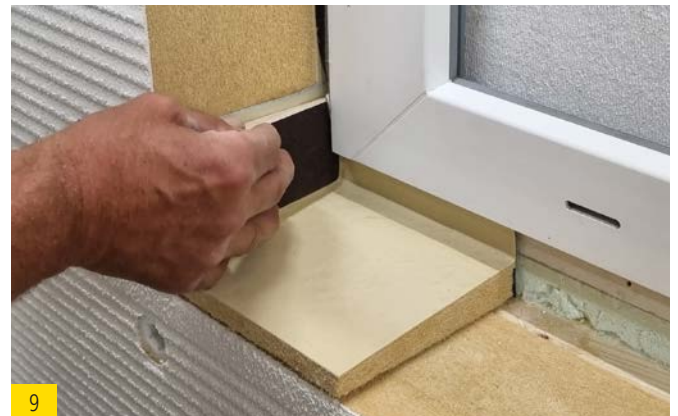
Placer les deux extrémités de cale d'étanchéité et les enfoncer proprement dans le coin de la tablette de fenêtre à l'aide d'un accessoire (par exemple une cale en bois).
