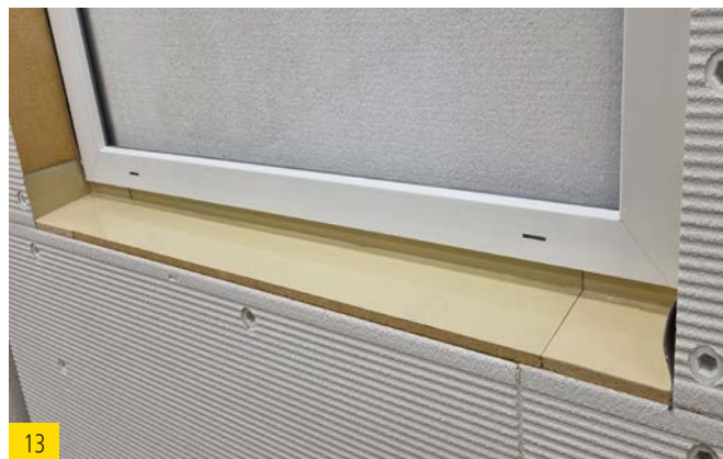
13 Le bord avant doit être au même niveau que le mur / le panneau de fibres de bois. Après contrôle, retirer à nouveau les trois pièces.
