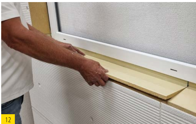
12 Enfoncer la cale d'étanchéité sous le cadre de la fenêtre et vérifier ensuite que l'ajustement est correct.
