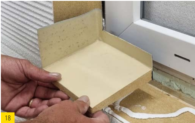
18 Positionner les extrémités de cale d'étanchéité dans les deux coins.
