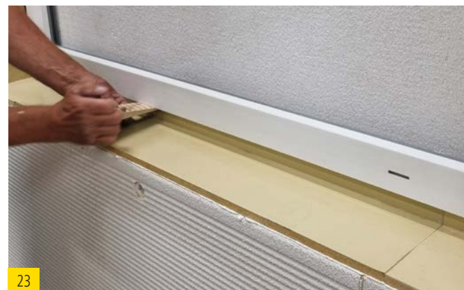
23 Appuyer fermement sur la bande adhésive sous le cadre de la fenêtre, également à l'aide d'un outil (par exemple une cale en bois).
