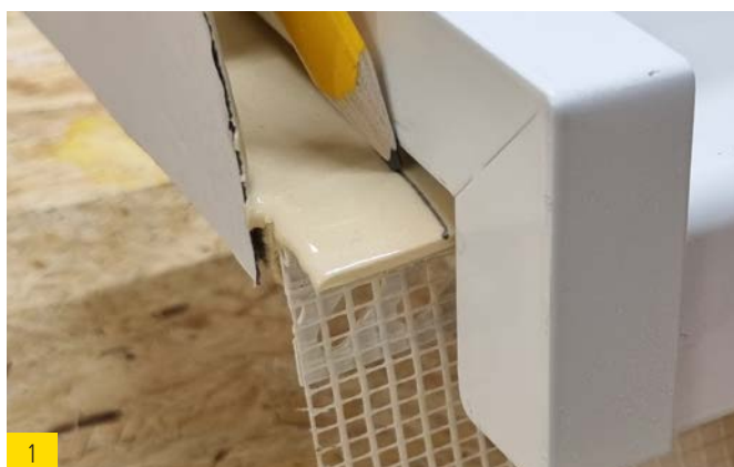
1 Tracer la longueur de la tablette de fenêtre sur les extrémités de cale d'étanchéité droite et gauche.
