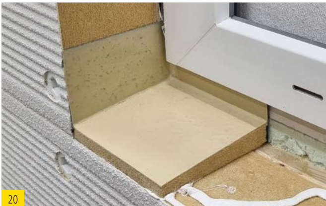
20 Important : S'assurer qu'il se forme à nouveau un « U » entre le cadre de la fenêtre et le panneau de fibres de bois (voir image n° 10).
