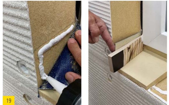
19 Appliquer best wood FDM WALL sur le côté bas de la tablette de fenêtre. À l'aide d'une cale, bien enfoncer ensuite l'extrémité de cale d'étanchéité entre le bord de la fenêtre et le panneau de fibres de bois.
