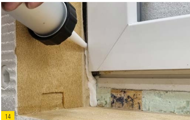
14 Jointoyer les coins gauche et droit avec best wood FDM WALL.
