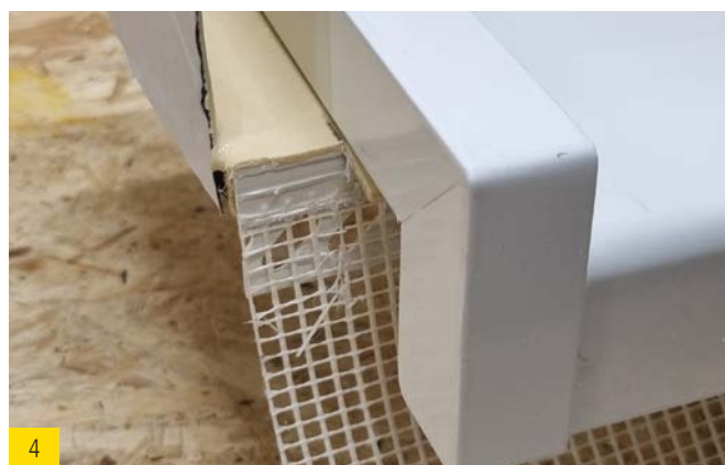
4 Profil de finition pour tablette de fenêtre à la même longueur.
