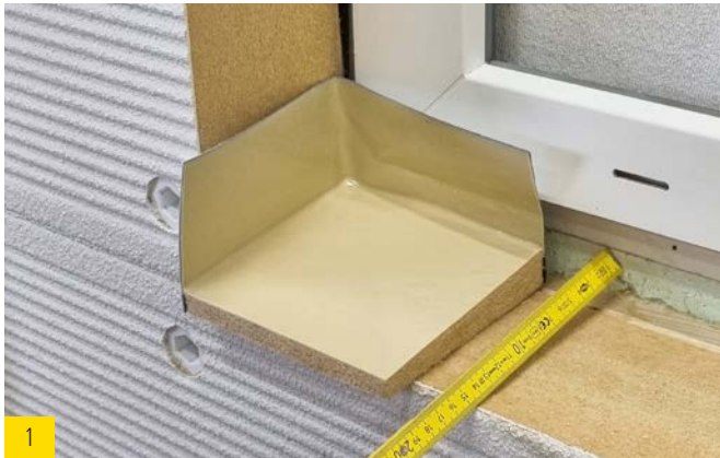
1 Mesurer la profondeur de la tablette de fenêtre.
