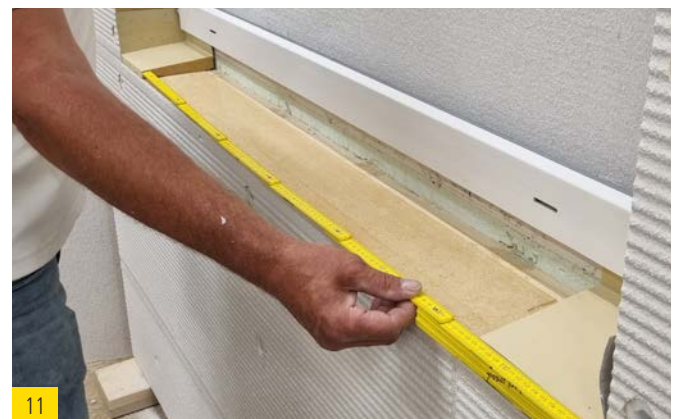
Mesurer l'espace entre l'extrémité de cale d'étanchéité gauche et droite et couper la cale d'étanchéité (partie centrale) à la bonne longueur.
