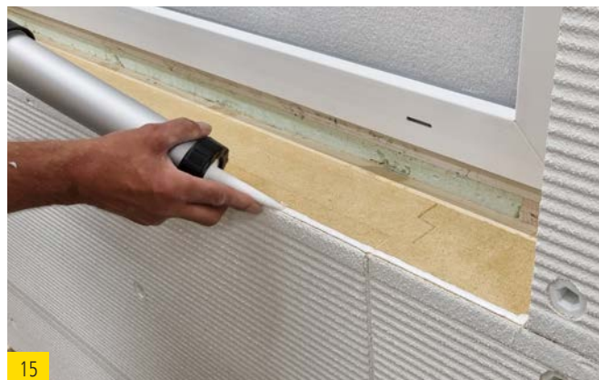
15 Appliquer best wood FDM WALL sur le bord avant.
