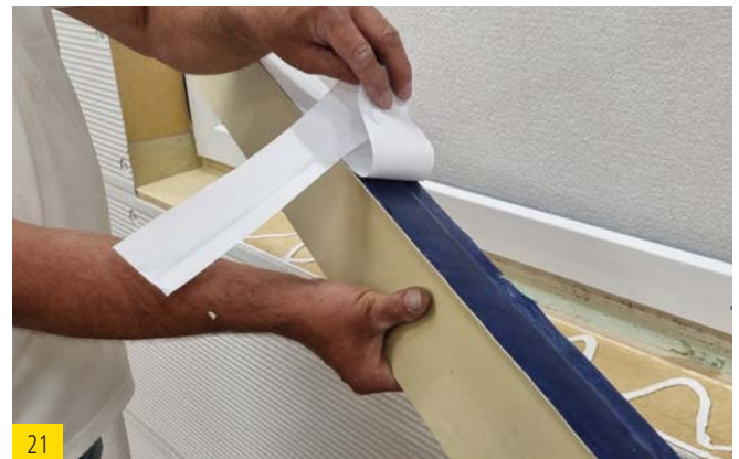
21 Retirer la bande de protection du ruban adhésif de la cale d'étanchéité déjà sciée.
