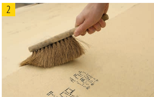
(2) Pour permettre la réalisation de raccords durables et étanches, il est indispensable d'enlever toutes poussières et sciures de la zone de collage. Soit par balayage ou en soufflant avec de l'air comprimé.
