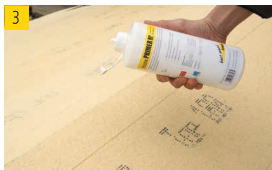
(3) Appliquer le TESCON PRIMER RP à l'aide d'un pinceau (4), ou rouleau synthétique ou avec le système TENAPP (5). Veillez à appliquer le produit sur une bande légèrement plus large que la largeur de l'adhésif utilisé.
