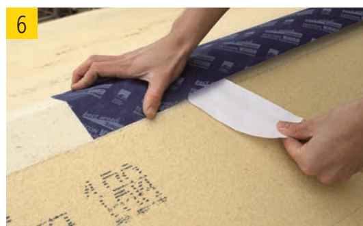
(6) Appliquer la bande adhésive TESCON VANA sur la zone préparée encore humide. Presser fortement et lisser à l'aide de la spatule de fixation PRESSFIX.
