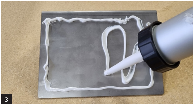
3 Appliquer FDM WALL sur l'équerre et la presser à l'arrière du LAMBREQUIN (quantité et espacement, se référer à la directive de mise en œuvre SITE)
