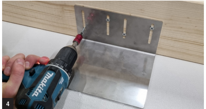
4 Visser l'équerre dans la traverse. Remarque: prévoir une équerre de renfort au droit d'un raccord entre panneaux
