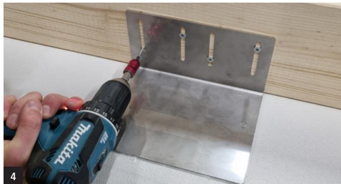
4 Visser l'équerre dans la traverse. *Remarques : En cas de raccords entre panneaux, il faut également prévoir une équerre au niveau du raccord*
