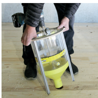
Placer l'aide au remplissage EASY FILL sur l'ouverture de la CLT BOX – DECKE FS
