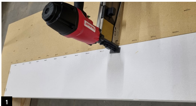
1 STURZBLENDE umlaufend auf halbe Ständer-/ Riegelbreite klammern
