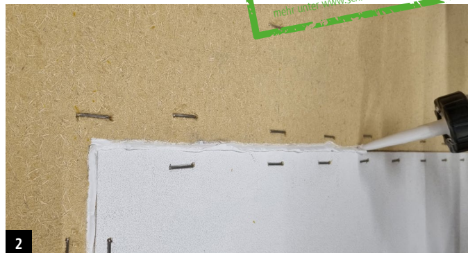
2 Fugen in Fassadenebene mit FDM WALL verschließen
