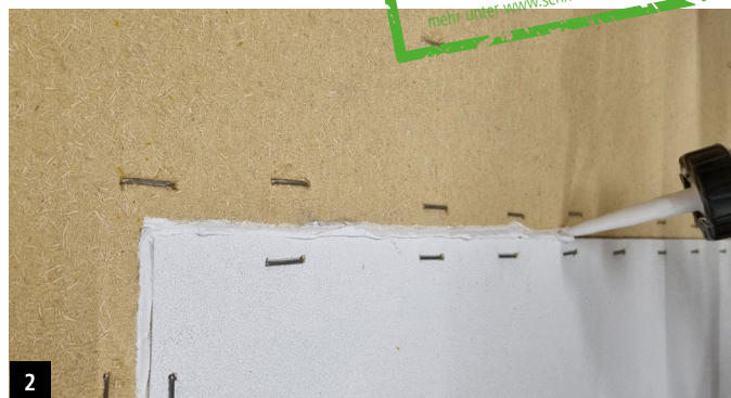
2 Fugen in Fassadenebene mit FDM WALL verschließen
