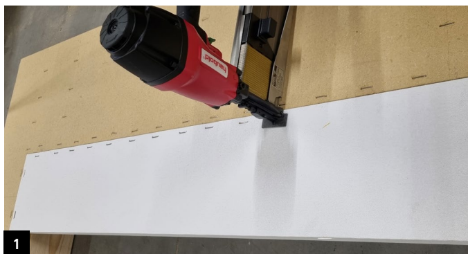
1 STURZBLENDE umlaufend auf halbe Ständer-/ Riegelbreite klammern
