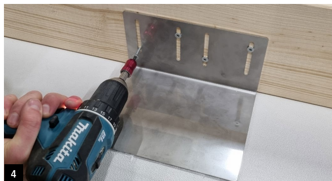
4 Winkel im Riegel verschrauben. Anmerkung: Bei Plattenstößen ist im Bereich des Stoßes ebenfalls ein Winkel vorzusehen
