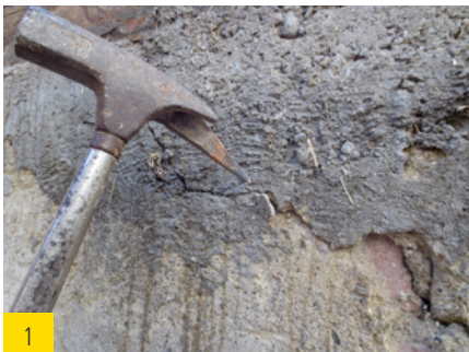
1 Lose Putzschichten entfernen.
