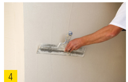
4 best wood Armierungsgewebe eingespachtelt.
