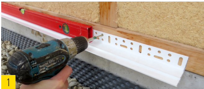
1 Sockelprofil waagrecht ausrichten und befestigen.
