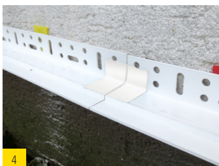
4 Stoß mit Klebeband abkleben.
