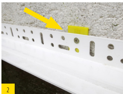
2 Distanzausgleich an Sockelschiene.
