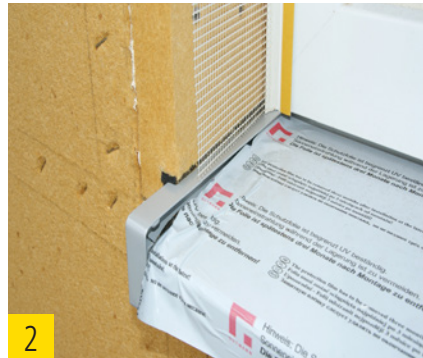
2 Teleskopanputzleiste bündig mit Innenkante Fensterbankendstück.
