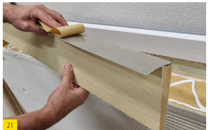
Das Klebeband des bereits zugesägten Dichtkeils abziehen
