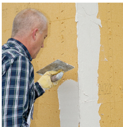
Klebe- und Armierungsmörtel (UP) aufziehen.
