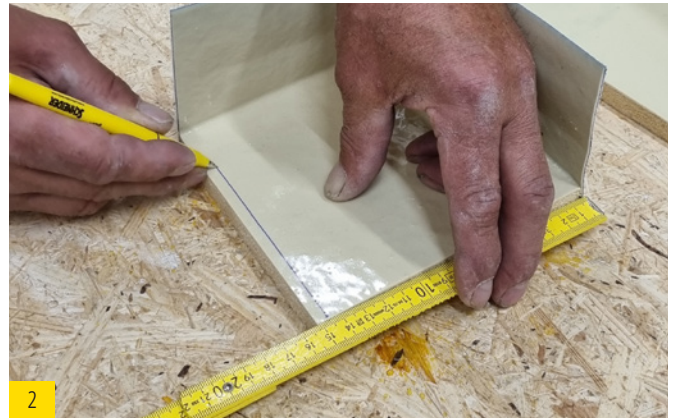
2 Dichtecke mit entsprechender Tiefe anzeichnen.
