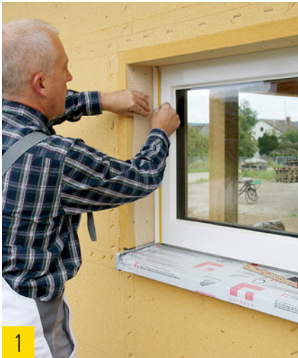
1 Teleskopanputzleiste ankleben.
