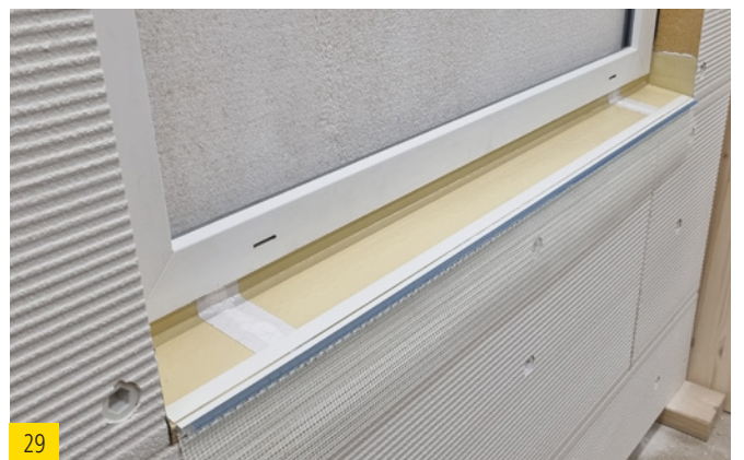
best wood Putzabschlussprofil ausgemittelt zwischen den Laibungen anbringen.
