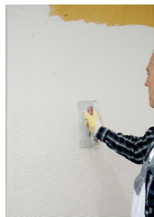
Zahnschicht herstellen.
