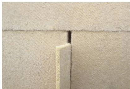
Verlegefugen mit Streifen aus best wood WALL 140/180 schließen.
