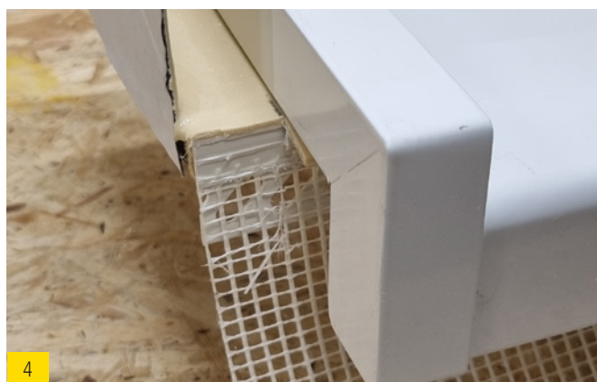
4 Putzabschlussprofil und Fensterbank auf gleicher Länge.
