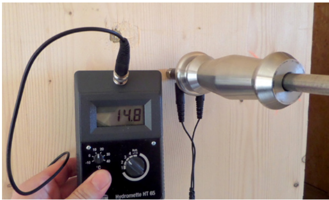
Holzfeuchte Holzständerkonstruktion \leq 18\% .
