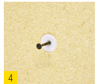
4 Mit 4–5 mm Schraube Anbauteil befestigen.
