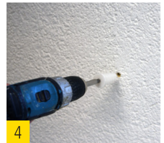
4 Spiraldübel mit TORX T40 oberflächenbündig mit verputzter Holzfaser-Dämmstoffplatte eindrehen.
