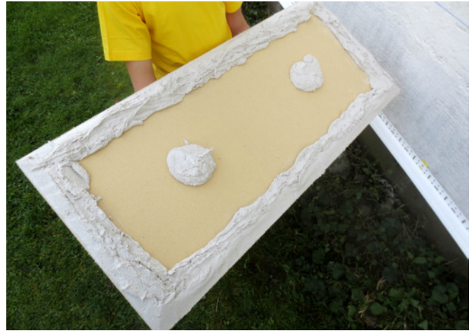
Auftrag Punkt-Wulst-Verfahren.
