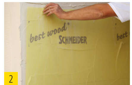
2 best wood Armierungsgewebe einlegen.
