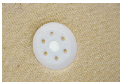
Dämmstoffschraubdübel plan mit best wood WALL 140/180 montiert.
