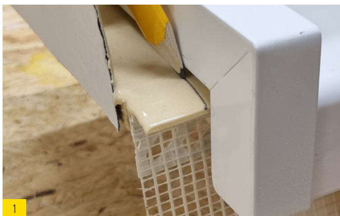
1 Fensterbanklänge auf rechtem und linkem Dichtkeil anzeichnen.
