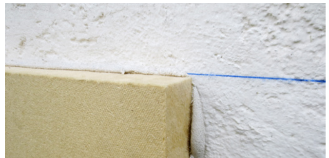
WALL 140 an waagerechter Schlagschnur ausrichten.
