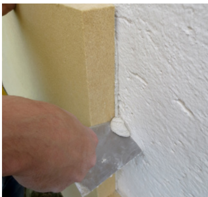
Seitlich austretendem Kleber entfernen.
