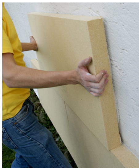
WALL 140 mit schiebenden Bewegungen anbringen.
