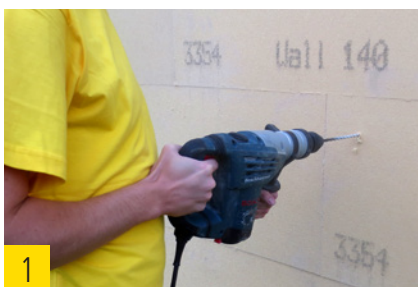
1 Vorbohren mit Schlagbohrmaschine.
