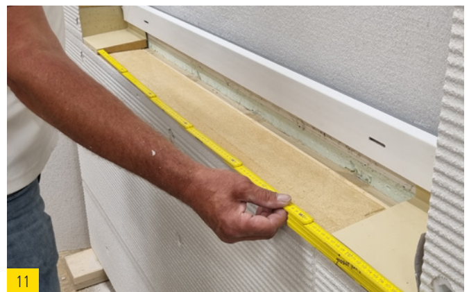
Den Zwischenraum von Dichtecke links zu rechts ausmessen und den Dichtkeil (Mittelteil) in richtiger Länge zuschneiden.
