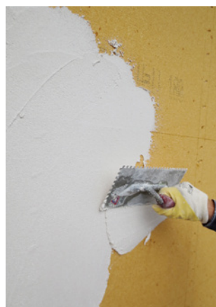
Klebe- und Armierungsmörtel (UP) aufbringen.
