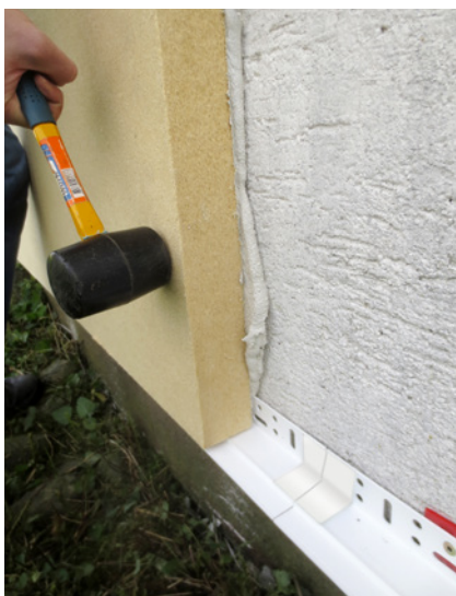
WALL 140 vollflächig auf Sockelschiene aufstellen.
