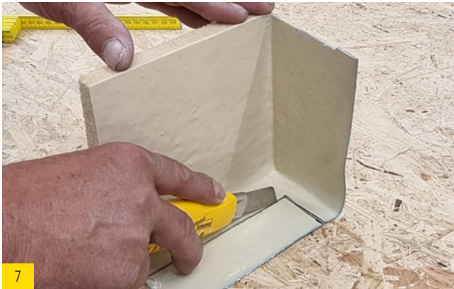
7 Die Dichtecken an die Fensterecken anpassen.
