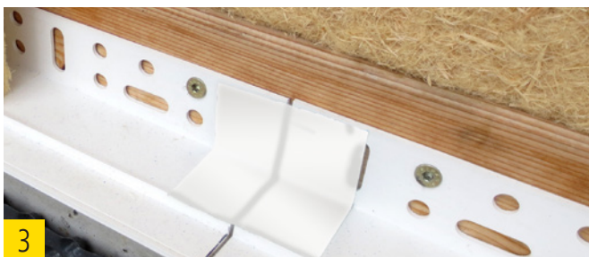
3 Stoß mit Klebeband abkleben.
