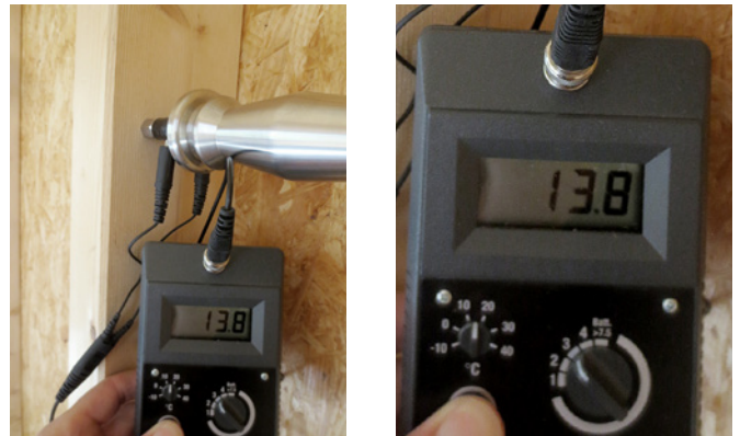
Holzfeuchte Holzständerkonstruktion \leq 18\% .
