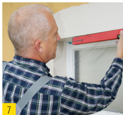
7 Gewebeeckwinkel horizontal und vertikal ausrichten.
