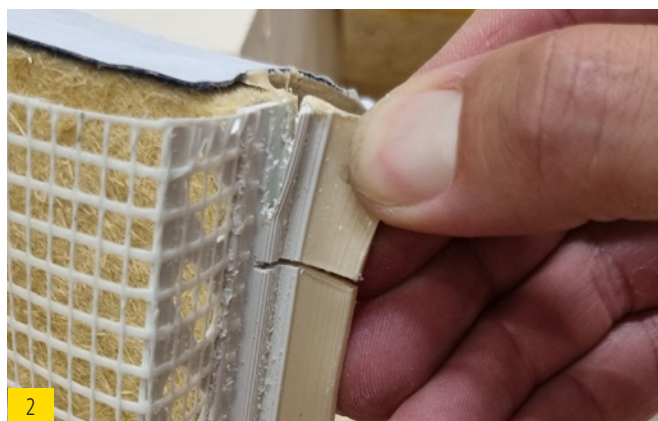
2 Putzabschlussprofil inkl. Gewebesteg auf angezeichnete Länge kürzen.
