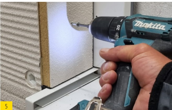
5 Laibungsplatte auf die Fensterbank aufsetzen, fest gegen den Fensterrahmen drücken und mit nicht rostenden Schrauben fixieren.
