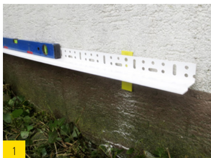
1 Sockelprofil waagrecht ausrichten und befestigen.
