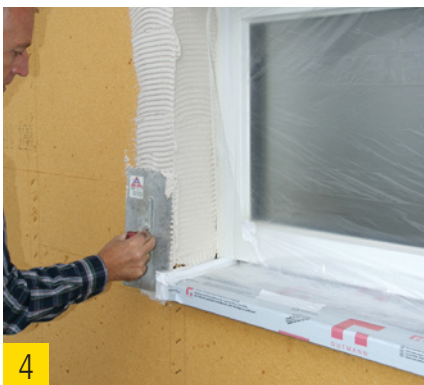
4 Klebe- und Armierungsmörtel UP in der Fensterlaibung und Außenecke aufbringen.
