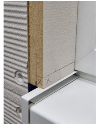
2 20 mm anzeichnen und markieren was ausgesägt werden soll.
