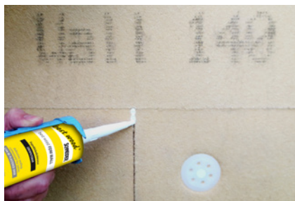
Verlegefugen mit FDM WALL schließen.
