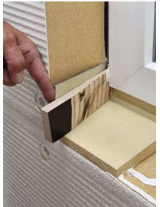
Stirnseitig best wood FDM WALL aufbringen. Mit Hilfe eines Keils anschließend die Dichtecke zwischen der Fensterkante und der Holzfaserplatte gut eindrücken.
