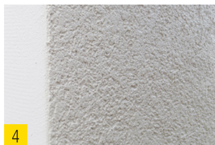
Fertig strukturierte Putzfläche.
