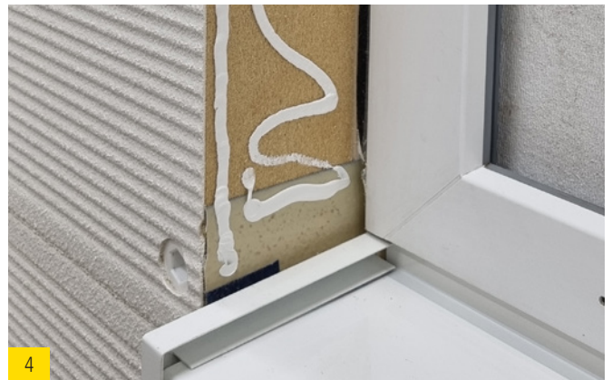
4 best wood FDM WALL seitlich auftragen.
