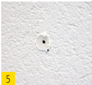
5 Überschüssige FDM WALL zwischen Putz und Spiraldübel entfernen.
