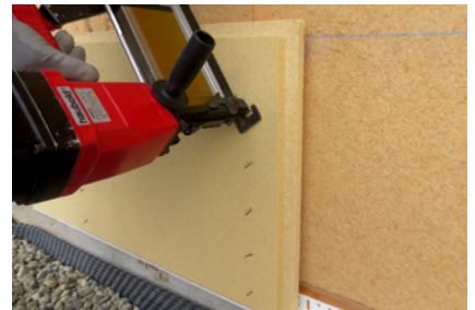
Befestigung mit Edelstahl-Breitrückenkammern.
