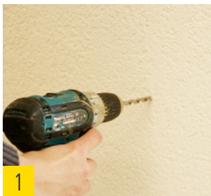
1 Unverputzte Holzfaser-Dämmstoffplatte mit 8 mm-Holzbohrer vorbohren.
