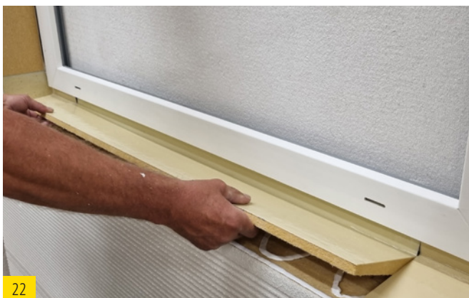
Den Dichtkeil zwischen den Ecken passgenau eindrücken
