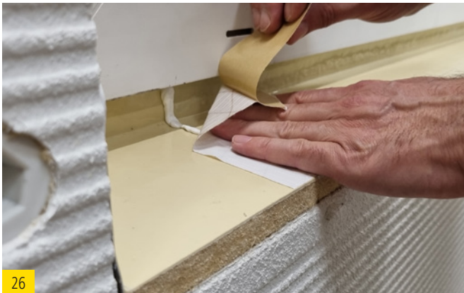
Denselben Stoß mit einem Streifen best wood KLEBEBAND überkleben.
