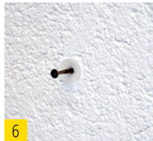
6 Mit 4–5 mm Schraube Anbauteil befestigen.
