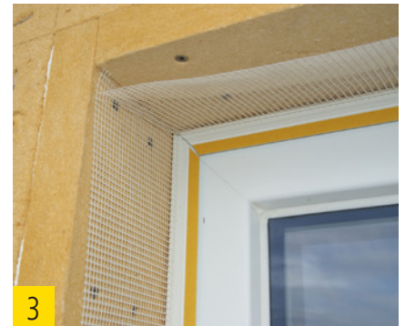
3 Teleskopanputzleiste in Ecke auf Gehrung geschnitten.
