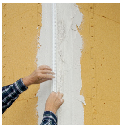
Gewebeeckwinkel einsetzen.
