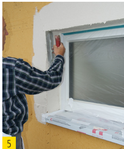
5 Teleskopanputzleiste einspachteln.
