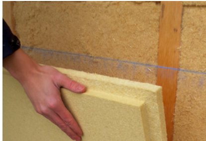
Erste Plattenreihe an waagrechter Schlagschnur ausrichten.
