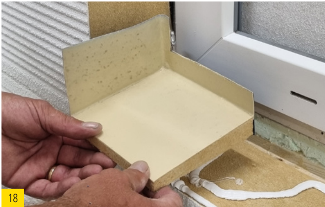
Die Dichtecken in beide Ecken positionieren
