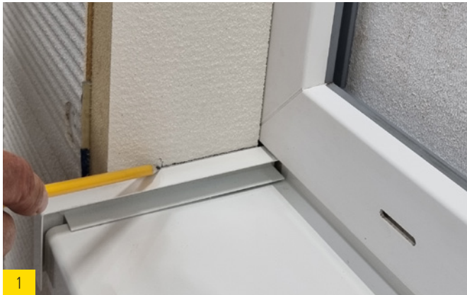
1 Ausklinken der 40 mm Laibungsplatte.
