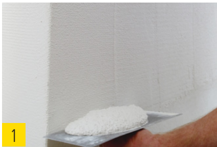
Oberputz mit Traufel aufbringen und auf Kornstärke abziehen.
