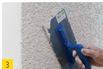
Oberputz mit Traufel strukturieren.
