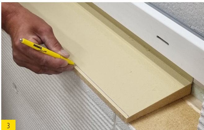
3 Dichtkeil mit entsprechender Tiefe anzeichnen.
