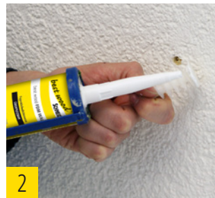
2 best wood FDM WALL unter Dübelteller auftragen.
