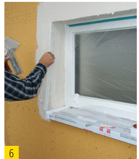
6 Gewebeeckwinkel einsetzen.
