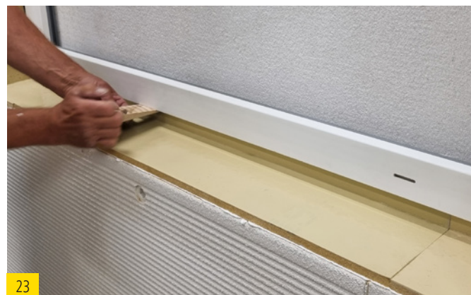
Unterhalb des Fensterrahmens ebenfalls mit einem Hilfsmittel (bspw. Holzkeil) den Klebestreifen fest andrücken
