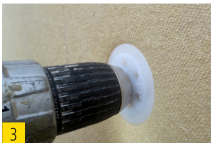
3 Dübel oberflächenbündig anziehen.
