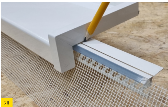
best wood Putzabschlussprofil Fensterbank auf die Länge der Fensterbank inkl. Endstücke zuschneiden.
