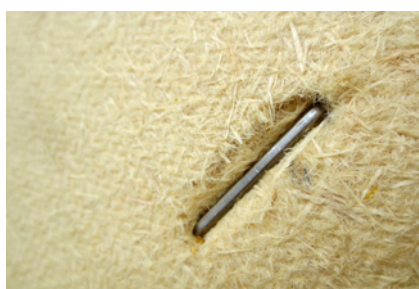
Edelstahl-Breitrückensklammer ca. 1 mm in der best wood WALL 180 vertieft.
