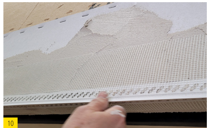
8 Links und Rechts des Stoßes jeweils mit einer Klammer fixieren. Danach die restlichen Klammern einbringen.
