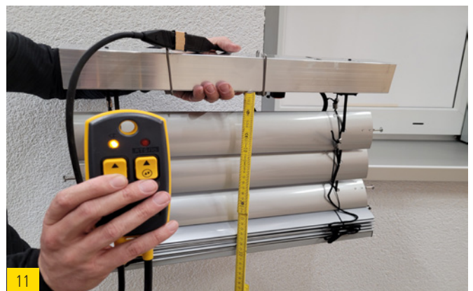
11 Fahrkabel anschließen und den Raffstore ca. 20–30 cm abfahren.
