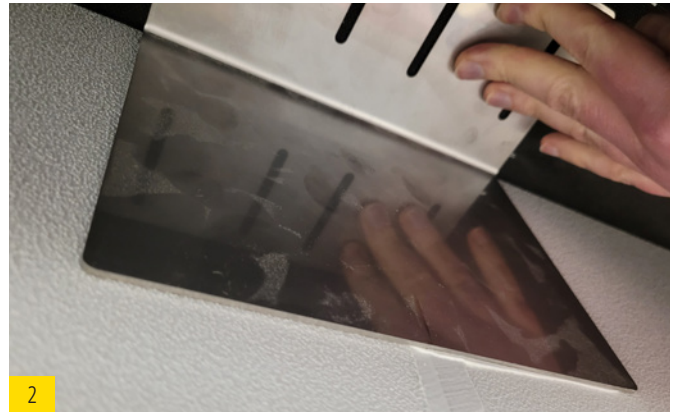
Winkel Rückseitig an die Sturzblende andrücken
