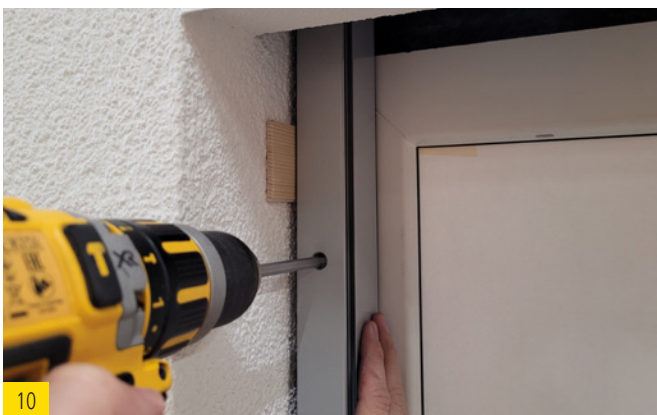
10 Führungsschienen mit den mitgelieferten Schrauben montieren.
