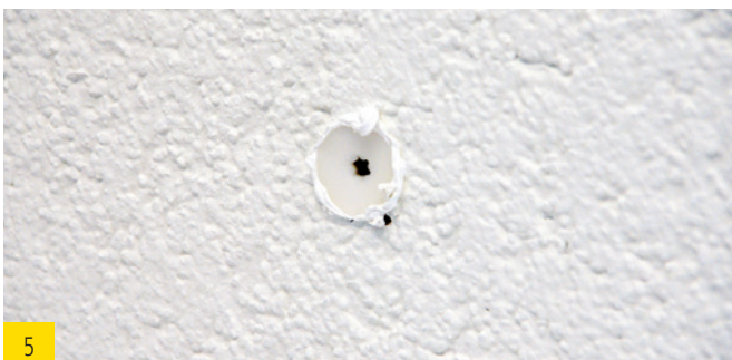
5 Überschüssige FDM WALL zwischen Putz und Spiraldübel entfernen.
