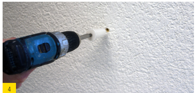
4 Spiraldübel mit TORX T40 oberflächenbündig mit verputzter Holzfaser-Dämmstoffplatte eindrehen.
