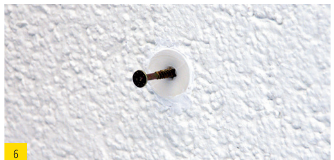
6 Mit 4–5 mm-Schraube Anbauteil befestigen.
