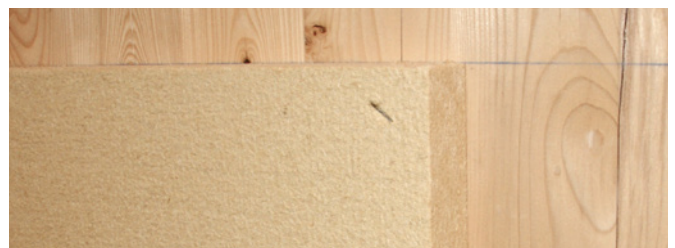
Erste Plattenreihe an waagrechter Schlagschnur ausrichten.
