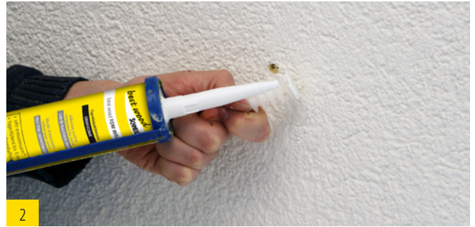
2 Fugen-Klebedichtmasse best wood FDM WALL zur Abdichtung verwenden.
