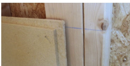
Erste Plattenreihe an waagrechter Schlagschnur ausrichten.
