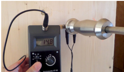
Holzfeuchte Holzständerkonstruktion \leq 18\% .
