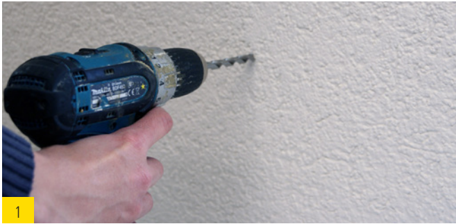
1 Verputzte Holzfaser-Dämmstoffplatte mit 8 mm-Holzbohrer vorbohren.
