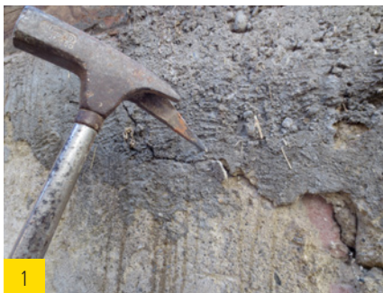
1 Lose Putzschichten entfernen.
