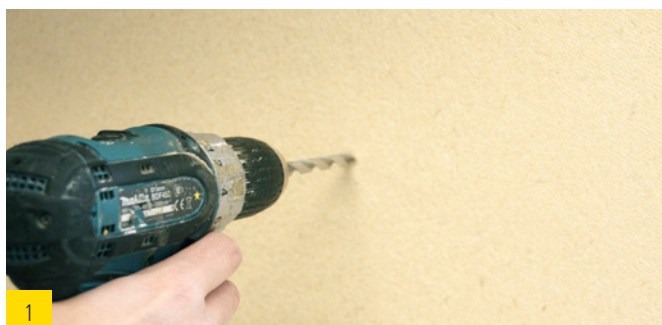
1 Unverputzte Holzfaser-Dämmstoffplatte mit 8 mm-Holzbohrer vorbohren.
