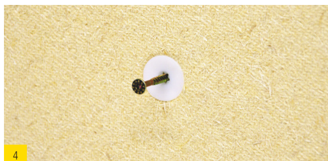
4 Mit 4–5mm-Schraube Anbauteil befestigen.
