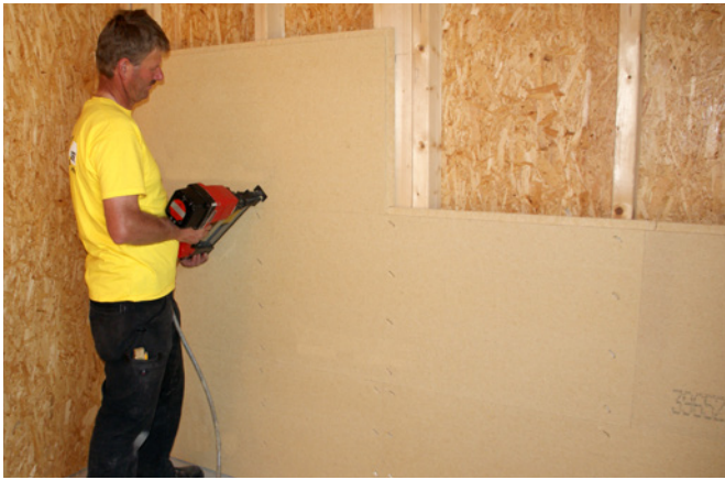
Befestigung mit Breitrückenklammern.
