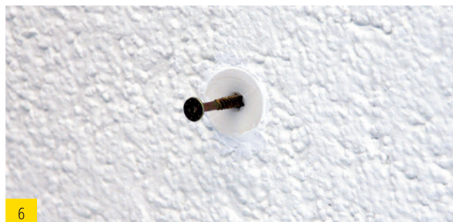
6 Mit 4–5 mm-Schraube Anbauteil befestigen.
