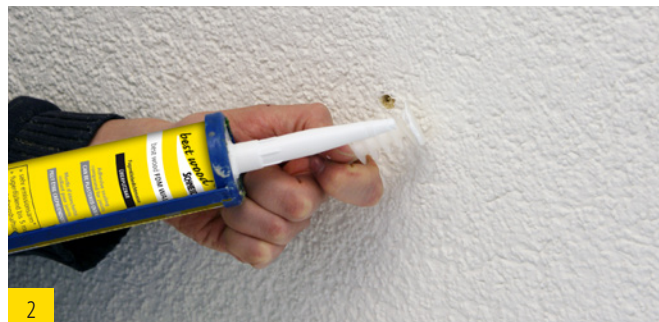
2 Fugen-Klebedichtmasse best wood FDM WALL zur Abdichtung verwenden.
