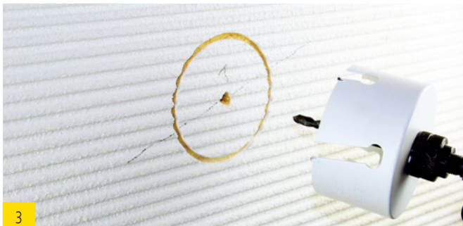
3 Putzschicht vorgebohrt
