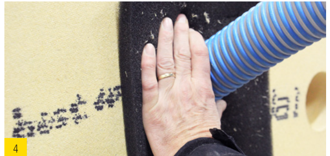
4 Einblasdämmung einbringen
