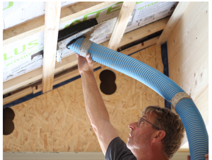
Dachkonstruktion mit Schlauchverfahren verfüllen.
