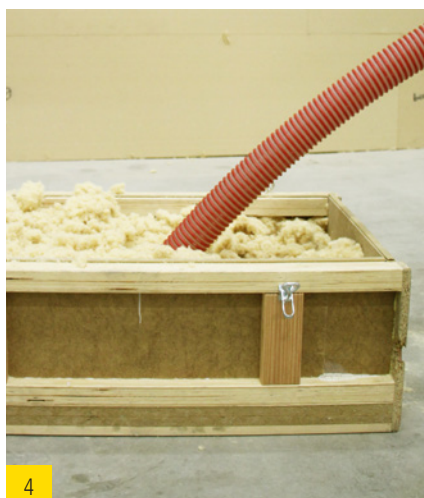
4 Offenes Aufblasen mit Schlauch
