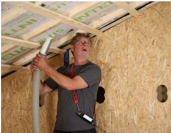
Dachkonstruktion mit Nadel 65 Ø verfüllen.
