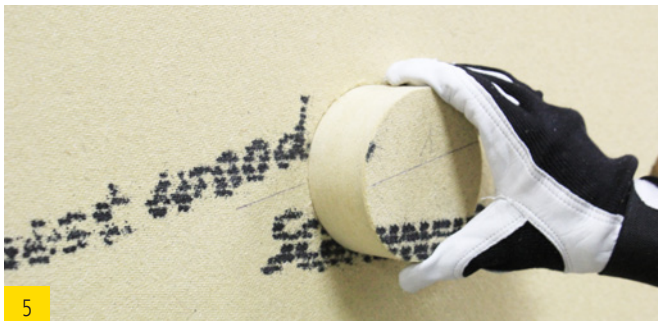
5 Bohrstopfen einsetzen ...
