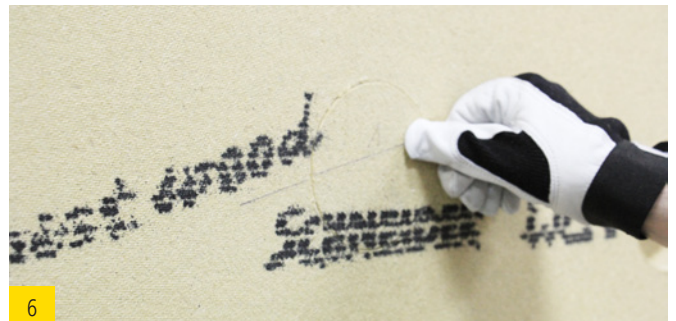
... und oberflächenbündig eindrücken
