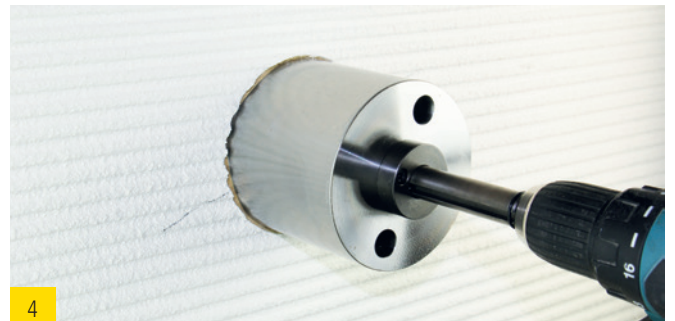
4 mit Lochsäge (ED) Öffnung herstellen
