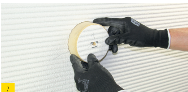
7 Bohrstopfen einsetzen ...
