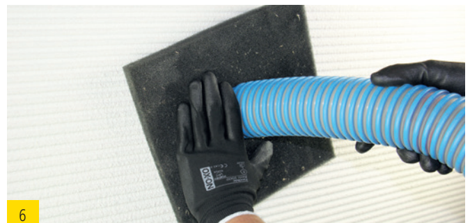
6 Einblasdämmung einbringen
