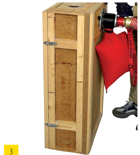
3 Verdichtetes Einblasen mit entlüfteter Drehdüse
