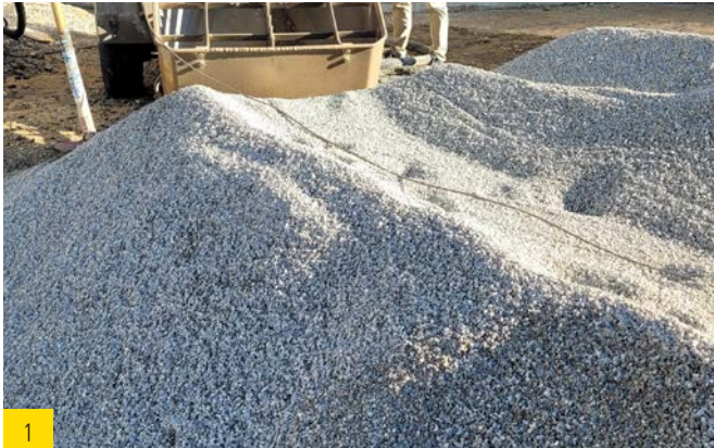
Lieferung des Splitts auf die Baustelle. Dieser darf maximal erdfucht sein und ist vor Regen und hoher Feuchtigkeit zu schützen
