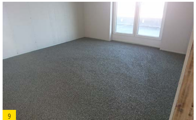
Eingebrachte und abgezogene Schüttung. Während des Abbindes darf diese nicht betreten werden. Nach dem Abbinden stellt die Schüttung keine Lauffläche dar. Sie darf nur zum Verlegen der Trittschalldämmung betreten werden.
