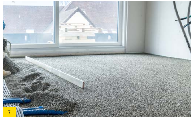
Abziehen des Splitts mittels Setzlatte auf die gewünschte Schütthöhe.
