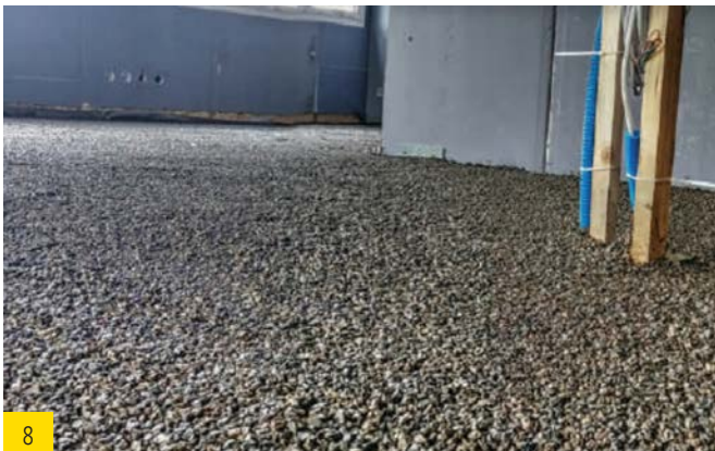
Eingebrachte und abgezogene Schüttung. Während des Abbindes darf diese nicht betreten werden. Nach dem Abbinden stellt die Schüttung keine Lauffläche dar. Sie darf nur zum Verlegen der Trittschalldämmung betreten werden.
