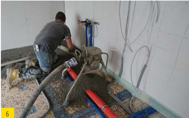
Befördern des angemischten Splitts und grobes Verteilen mittels Estrichpumpe.
