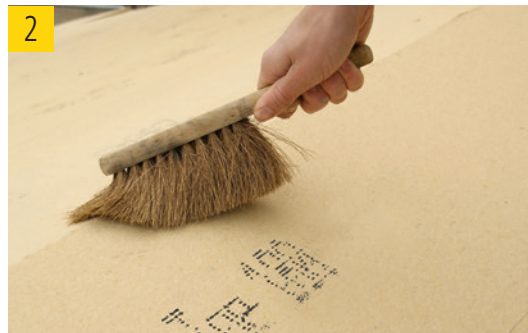
(2) Um einen dauerhaften Anschluss herzustellen, muss der Untergrund staubfrei sein. Staub und Sägespäne mittels Abkehren oder Druckluft vom Untergrund entfernen.
