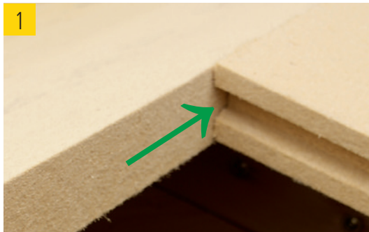
(1) best wood Holzfaser-Dämmstoff muss an allen Anschlüssen fugenfrei auf Gehrung geschnitten und verlegt werden, um Wärmebrücken in der Dämmebene zu vermeiden.
