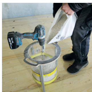
1/2 Sack Schüttung einfüllen
