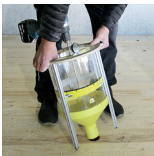
EASY FILL Einfüllhilfe über die Öffnung der CLT BOX – DECKE FS stellen
