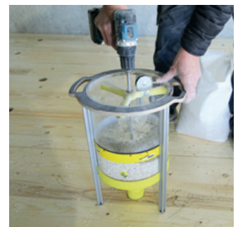
Mit Hilfe eines Akkuschaubers die Schüttung mit niedriger Drehzahl in die CLT BOX – DECKE FS einbringen
