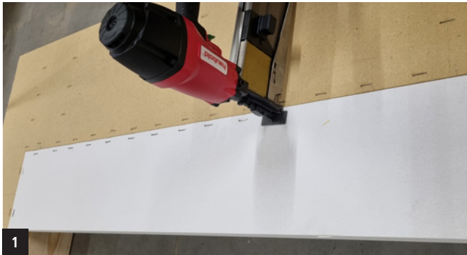
1 STURZBLENDE umlaufend auf halbe Ständer-/ Riegelbreite klammern
