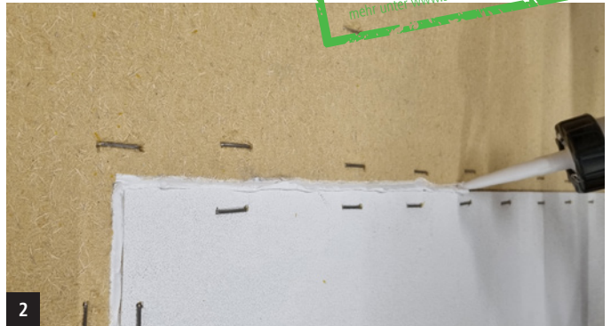
2 Fugen in Fassadenebene mit FDM WALL verschliessen
