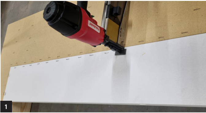
1 STURZBLENDE umlaufend auf halbe Ständer-/ Riegelbreite klammern
