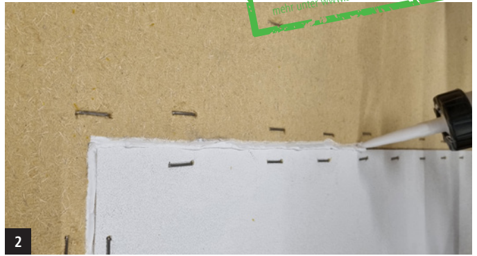
2 Fugen in Fassadenebene mit FDM WALL verschließen
