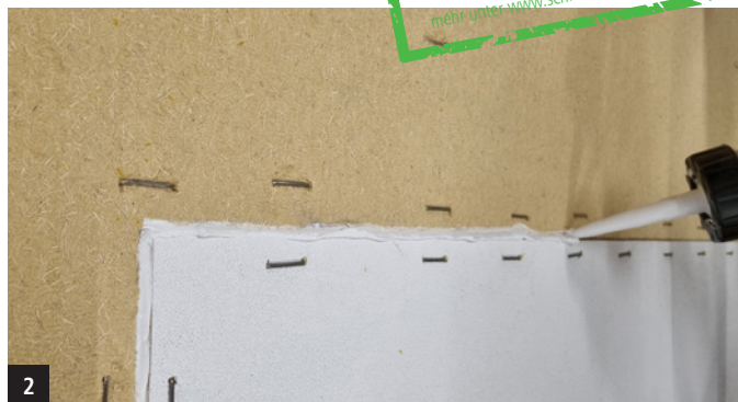
2 Fugen in Fassadenebene mit FDM WALL verschließen
