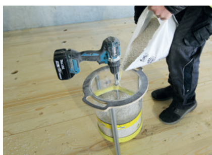
1/2 Sack Schüttung einfüllen
