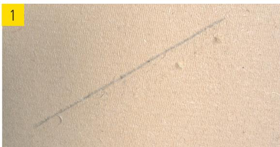
Position der Bohrung mit einem Strich markieren, als Anhaltspunkt für korrektes wiederverschließen.
