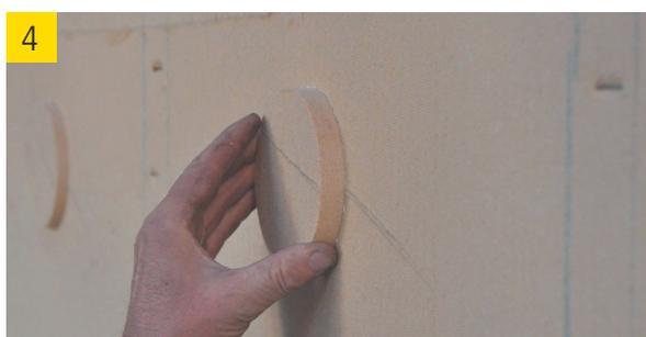
4 Bohrkern entsprechend der Markierung einsetzen
