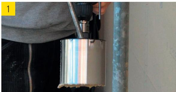
1 Den Bohrkern mit einem Stab aus der best wood Lochsäge herausschieben
