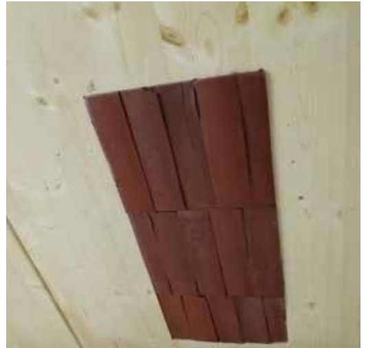
Hilti Brandschutzstein CFS-BL P in der CLT BOX
