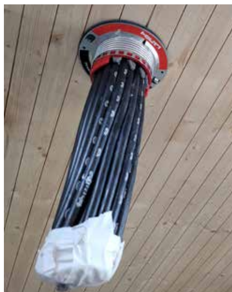
Hilti Brandschutzhülse CFS-SL GA in der CLT BOX
