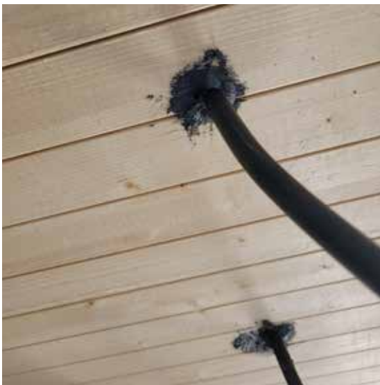
Hilti Brandschutzdichtmasse CP 611A in der CLT BOX
