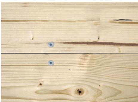
Bei Decken mit einem stumpfen Stoß die Kreuzverschraubung nach statischer Berechnung einbringen.
