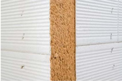
Am Gebäudeaußeneck mit der WALL 140/180 um die Putzstärke zurückbleiben, damit die Schichtstärken beim Einspachteln des Gewebeeckwinkels eingehalten werden können. Passgenaue Fugen in der Verlegefläche und senkrechte Schnittkanten müssen nicht abgedeckt werden.
