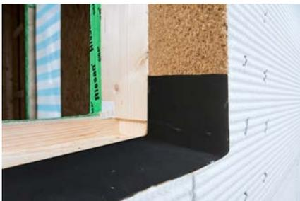
Horizontale Plattenkanten an Fensterbrüstungen oder an Attika sind vor direkter Bewitterung mittels geeigneter Abdeckung zu schützen. An der Fensterbrüstung kann dies z. B. mit der Herstellung der 2. Dichtebene bewerkstelligt werden.
