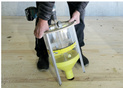
EASY FILL Einfüllhilfe über die Öffnung der CLT BOX – DECKE FS stellen
