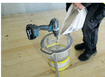
1/2 Sack Schüttung einfüllen
