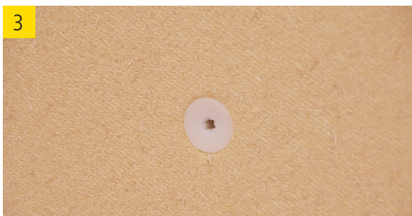
3 Schraubdübel oberflächenbündig montieren.
