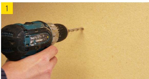
1 Unverputzte Holzfaser-Dämmstoffplatte mit 8 mm Holzbohrer vorbohren.
