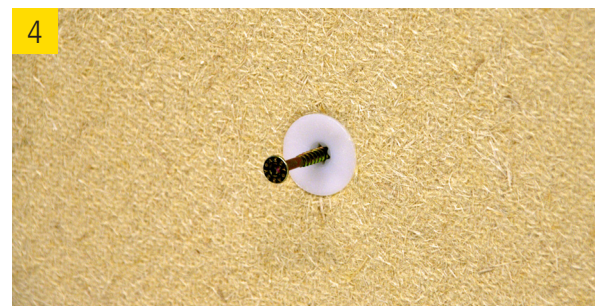
4 Mit 4-5mm Schraube Anbauteil befestigen.
