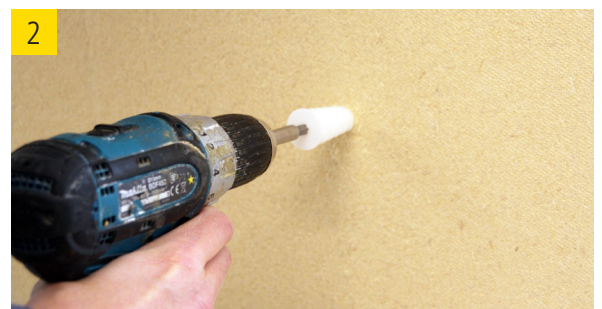
2 Spiraldübel mit TORX T40 in unverputzter Holzfaser-Dämmstoffplatte eindrehen.
