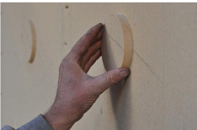
Bohrkern entsprechend der Markierung einsetzen.
