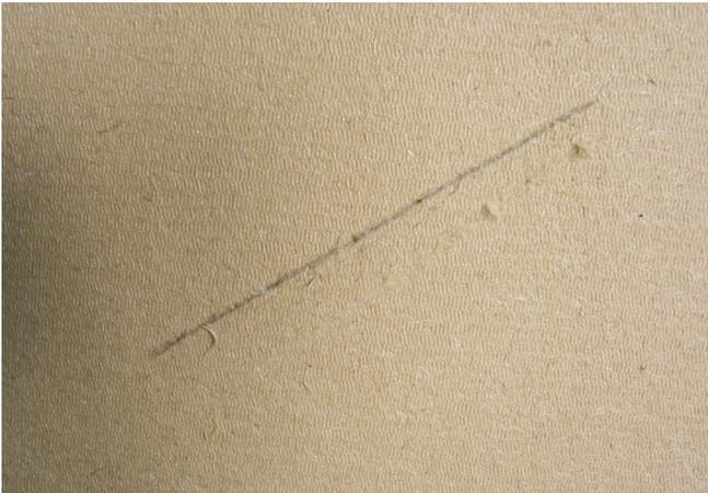
Position der Bohrung mit einem Strich markieren, als Anhaltspunkt für korrektes Wiederverschließen.
